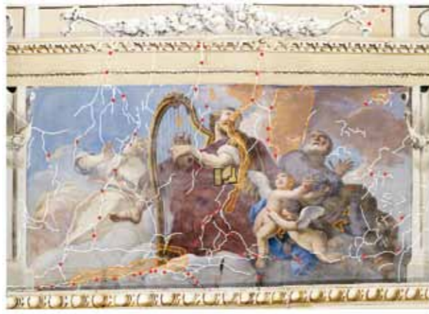
Tracce delle sezioni Punti di accostamento dell'intonaco Area di intaglio storico stratigrafico
