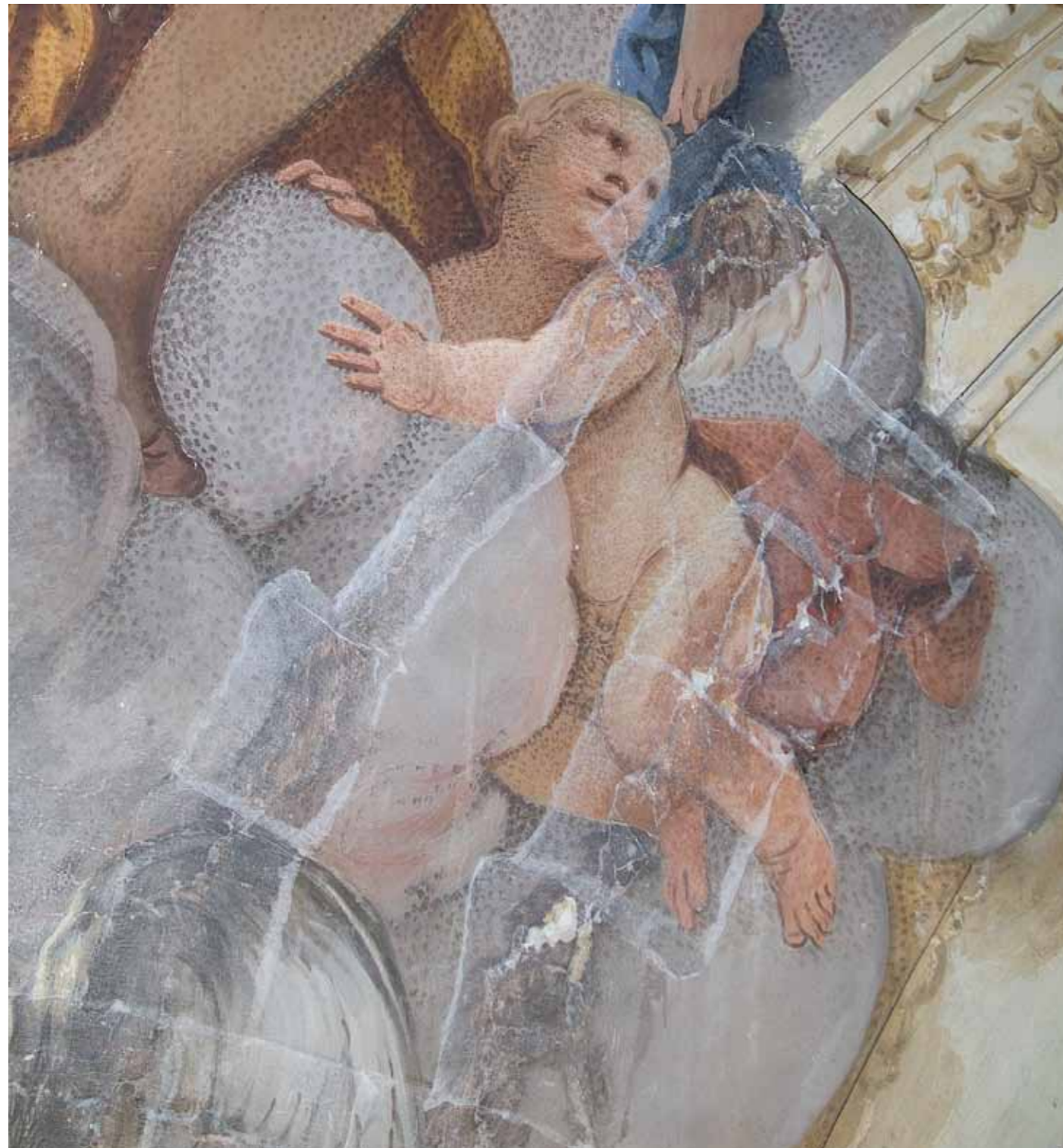
Applicazione di bendaggi per fissare le parti distaccate sui pennacchi
