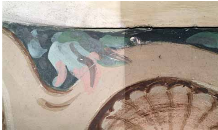
Particolare con campione di pulitura.
